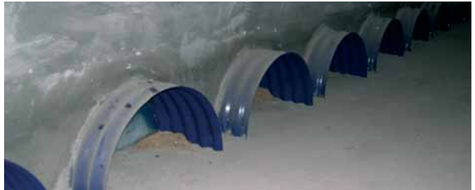
Tørrieriet, hvor afstanden mellem tørrekanalerne kun er 10 cm.
