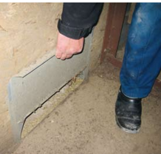
Hans Henrik lukker altid skodderne i hovedkanalen, når frøet er færdigtørret for at forhindre luften i at cirkulere
